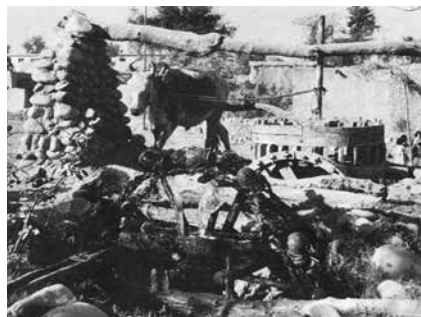
Slika 4. Sakija – uređaj koji pokreće životinjska snaga
